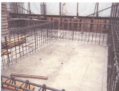
沙羅の家 大岡山の工事
